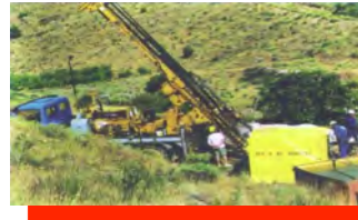
Sondeo inclinado S-10
