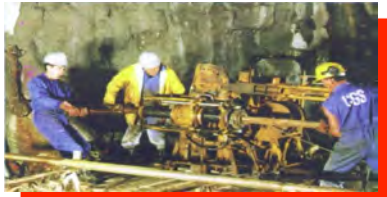
Perforación horizontal en el frente de excavación
